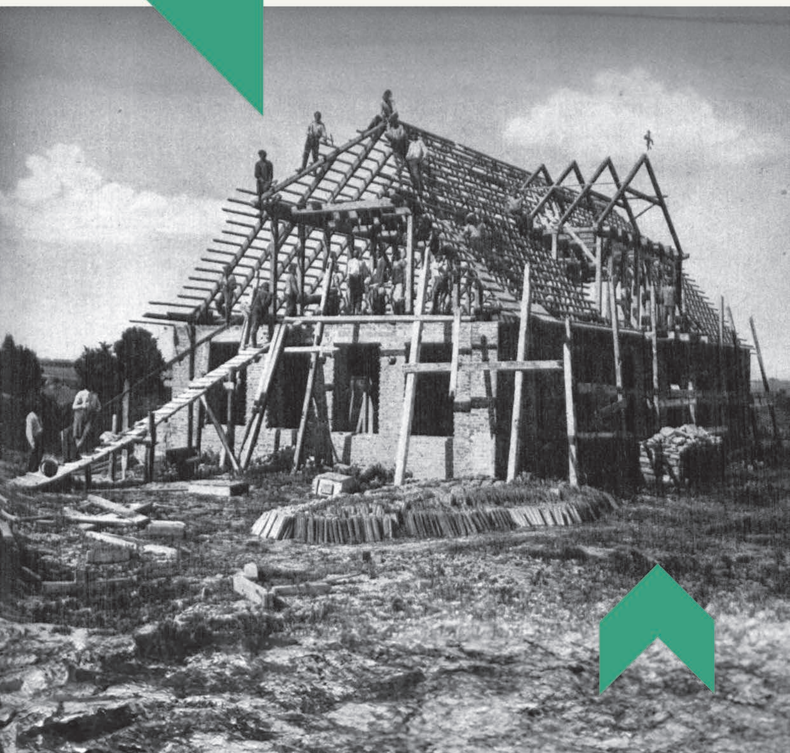
▼ Budowa domu ludowego w Woli Rycerskiej wznieśionego przy pomocy KDP. Fot. Na strażnicy i w domu, Warszawa 1938, s. 281.
