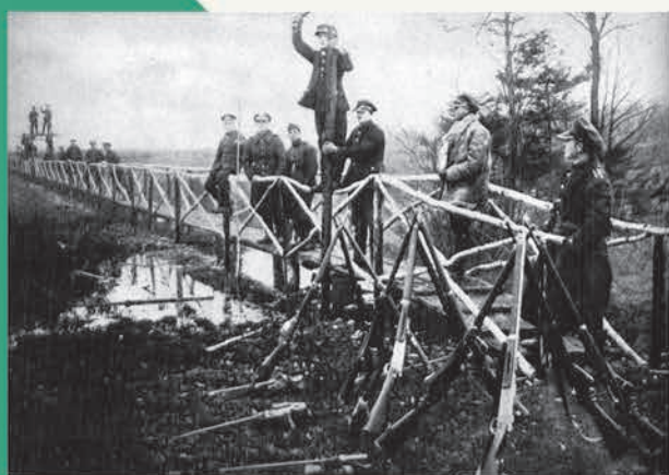
▲ Budowa kładki przez żołnierzy Korpusu na bagnach. Fot. Na strażnicy i w domu, Warszawa 1938, s. 200.
