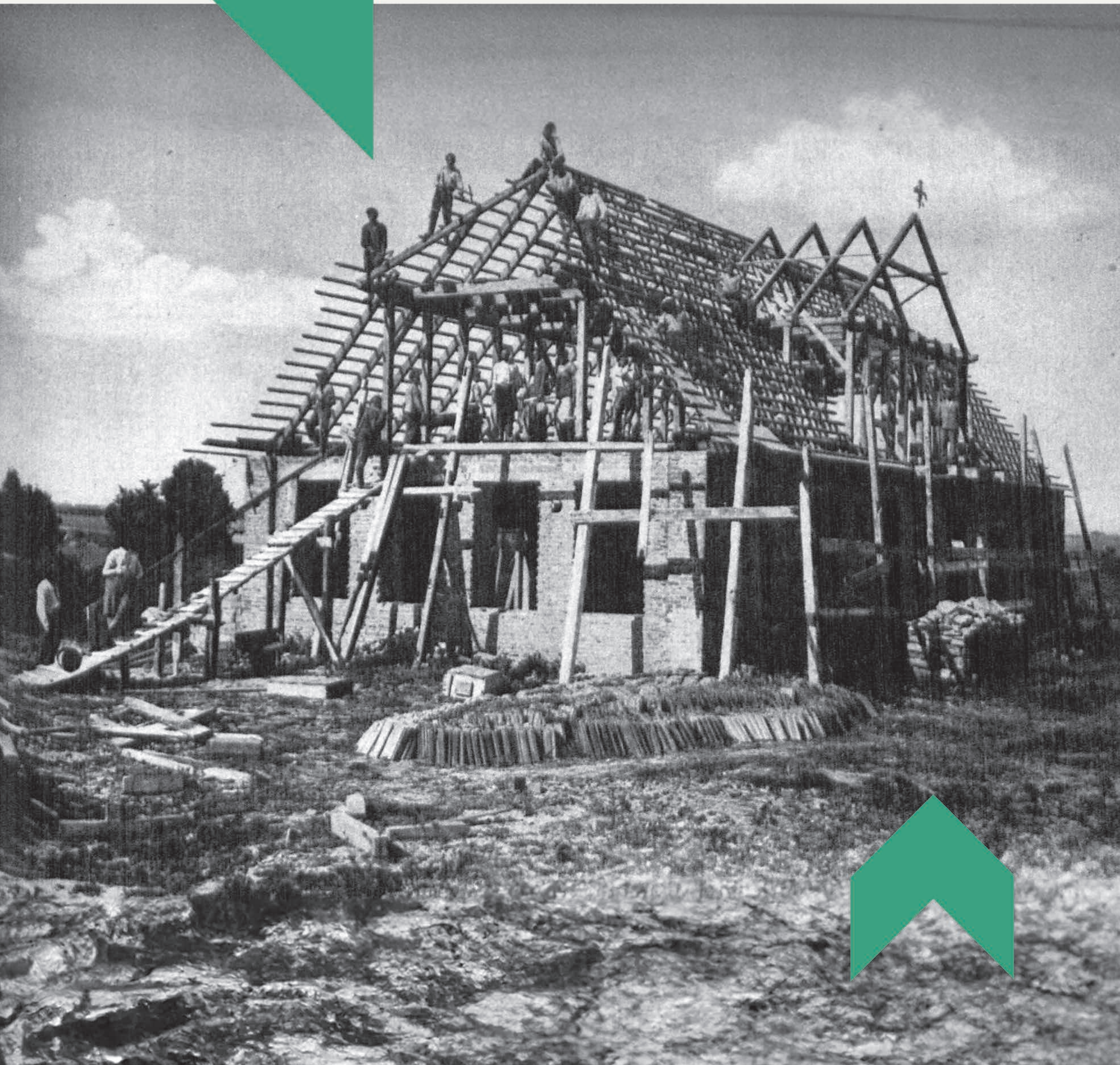
▼ Budowa domu ludowego w Woli Rycerskiej wzniesionego przy pomocy KOP. Fot. No strażnicy i w domu , Warszawa 1938, s. 261.
