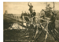
Budowa kładki przez bagna przez żołnierzy KOP
